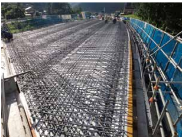
写真3 床板の型枠・鉄筋施工完了
