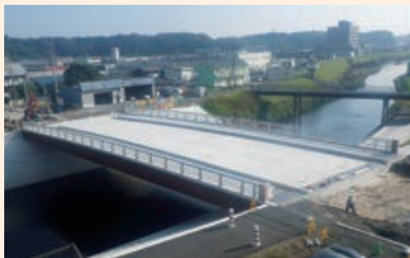
【ご発注者】 国土交通省 九州地方整備局 大隅河川国道事務所 【工事名】 肝属川沢尻橋架替（上部工）工事 【鋼重】 324.4トン
