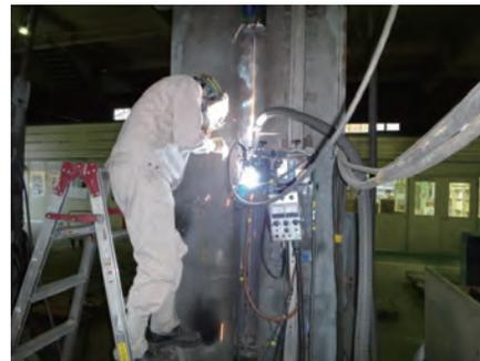
写真5 SEG 溶接施工試験状況
