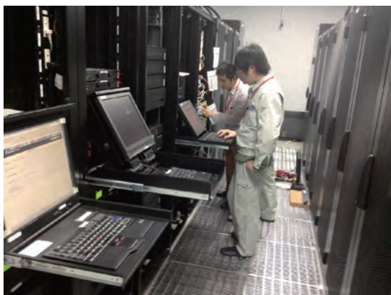
写真 2 移設作業の様子 (NetLink 伊万里)
