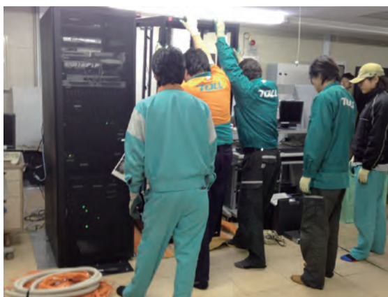
写真 1 移設作業の様子 (伊万里サーバールーム)
