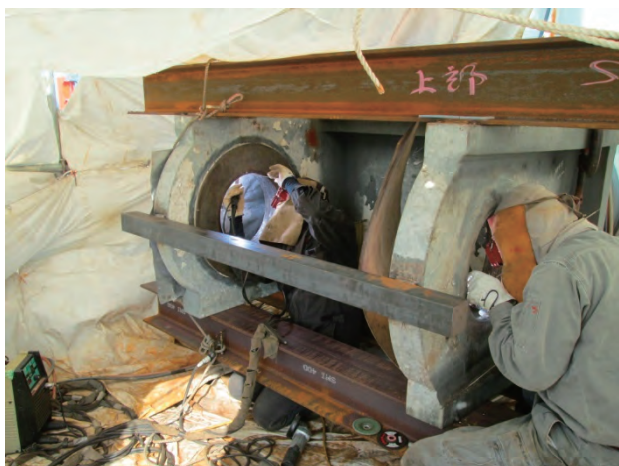
写真 21 溶接補修状況
