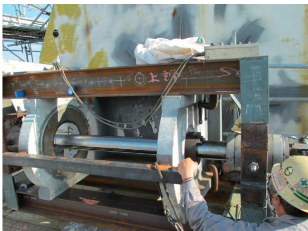
写真 22 肉盛溶接後、ボーリング加工
