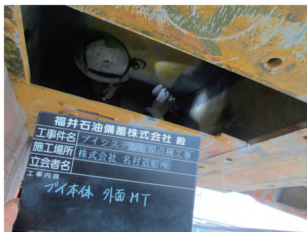
写真4 磁粉探傷試験状況
