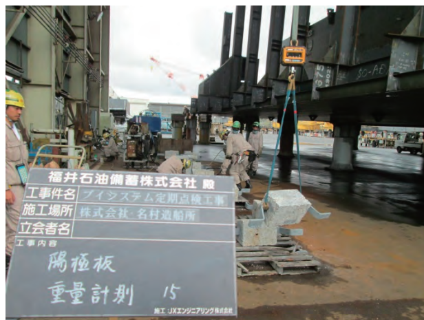
写真3 陽極板重量計測状況
