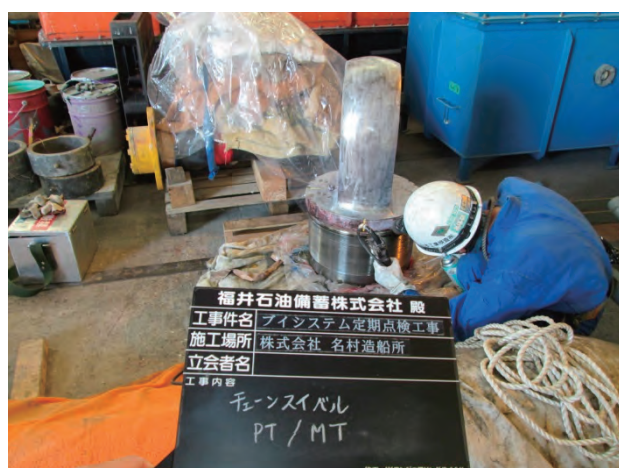
写真 30 非破壊検査状況
