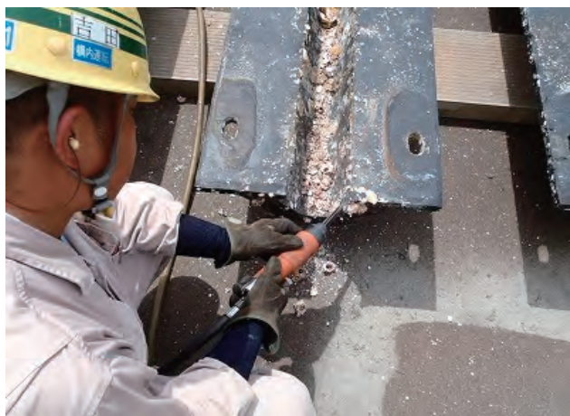
写真2 防舷材手入れ状況
