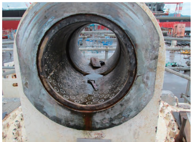
写真 19 軸受ブッシュ抜取状況
