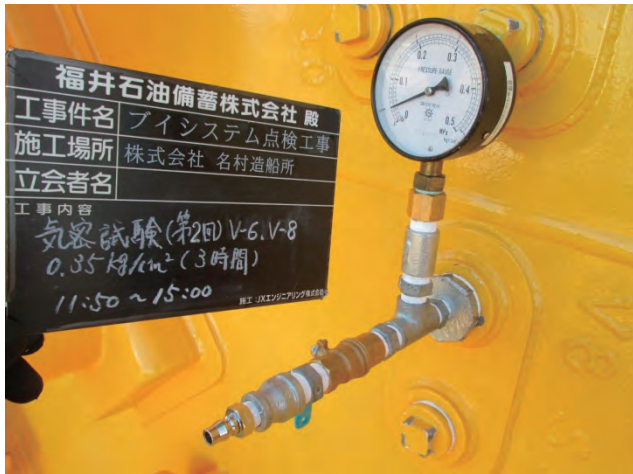
写真6 気密試験状況
