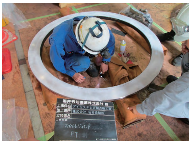
写真12 スイベルジョイント部品の検査状況
