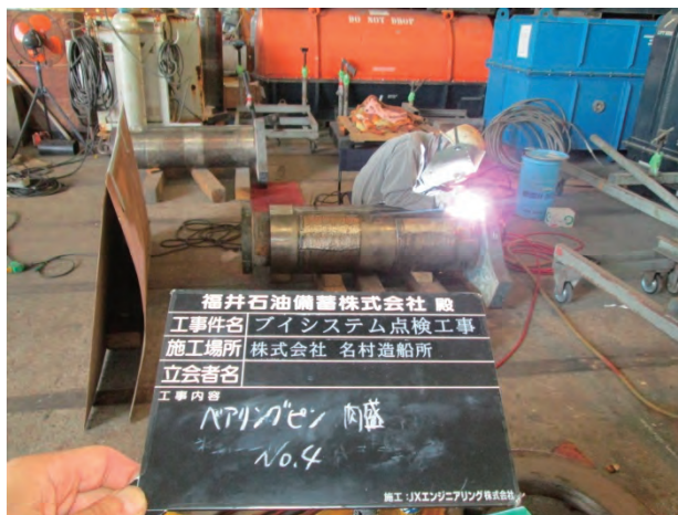
写真 23 軸ピンの溶接補修状況
