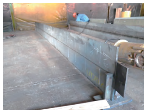
写真11 突合せ溶接継手の全景
