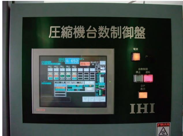
写真3 圧縮機台数制御盤
