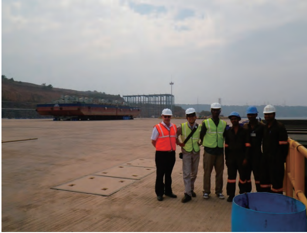
写真15 建設中の修繕ヤード
