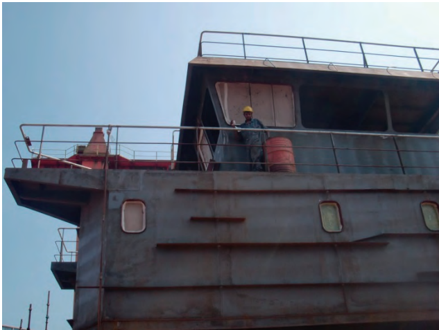
写真 10 薄板鋼板への歪防止材の設置
