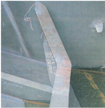
写真1 ロンジナックル構造
