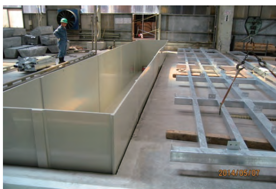
写真4 樹脂コーティング液槽 (現地据付中)
