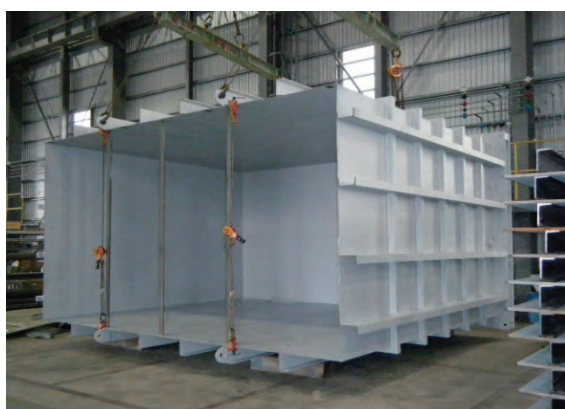
写真6 硝塩酸循環タンク (製作状況)
