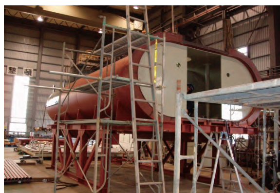
写真5 回収酸タンク (製作状況)
