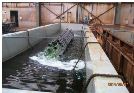
写真3 塩酸槽 (現地の使用状況)
