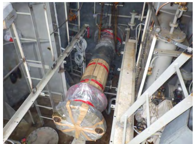
写真5 主機搭載前の軸周り(軸挿入済)
