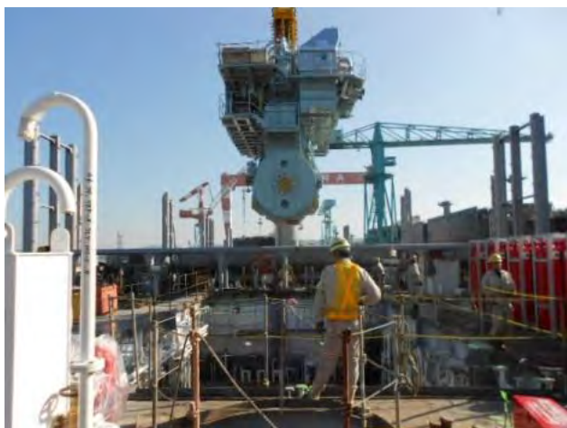
写真7 AU開口からの主機搭載(34BC)
