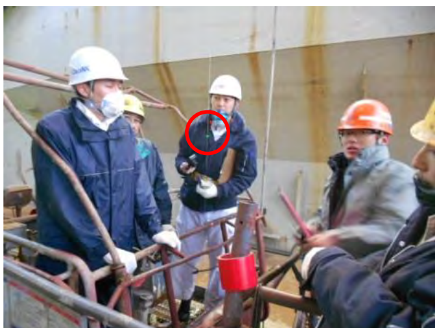
写真 19 検査時風景 ※船主殿・船級殿の確認で検査終了
