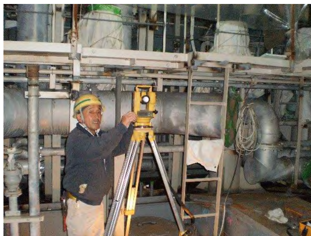
写真1 エンジンピット内に設置のトランシット
