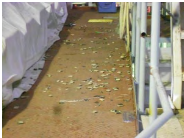
写真 20 AU 溶接時の通路(進水前) ※ゴミ等が大量に落ちてくる
