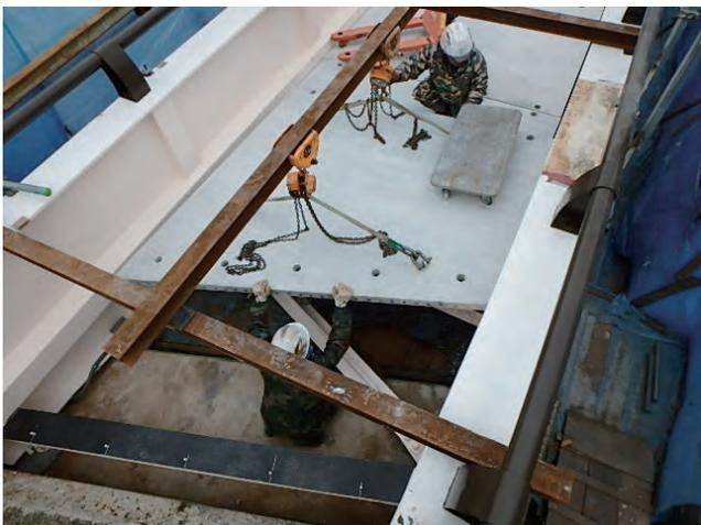
写真11 PC床板設置状況
