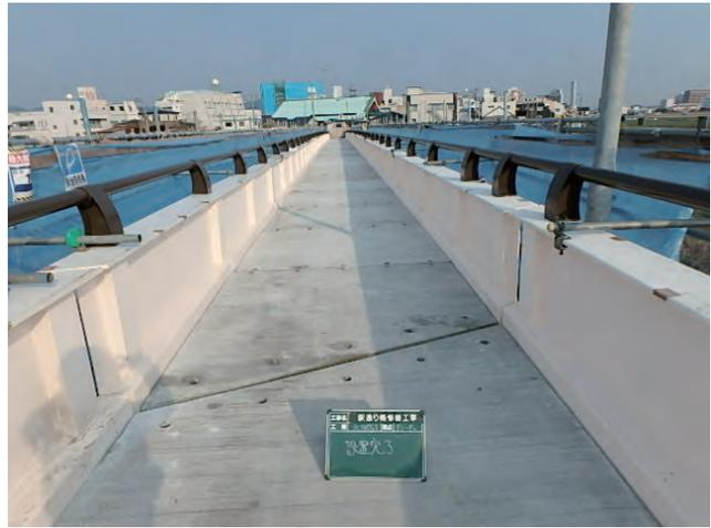
写真12 PC床板設置完了
