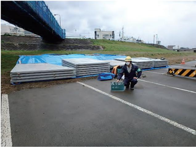
写真10 PC床板仮置き状況
