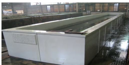
新型 PP 製酸洗槽の設置状況
