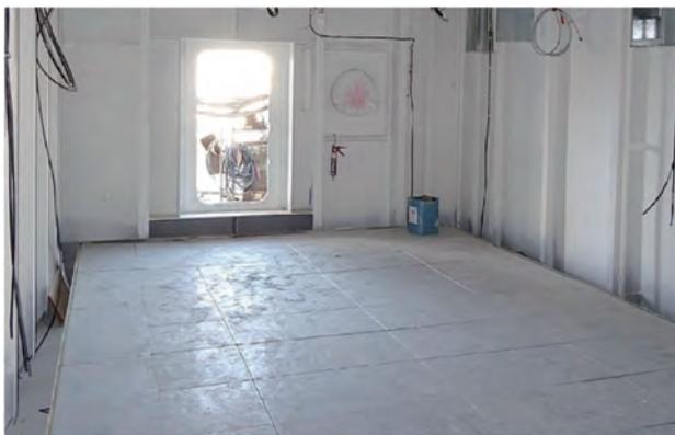
写真1 浮床の施工状態
