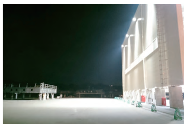
写真4 屋外投光器点灯時
