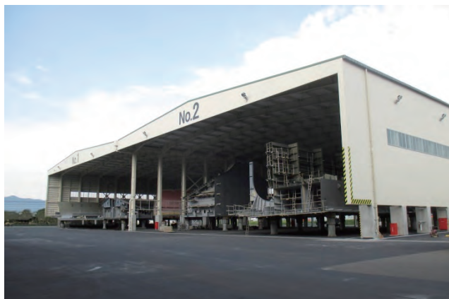
写真1 ブロックヤードNo.1~2 (A棟)
