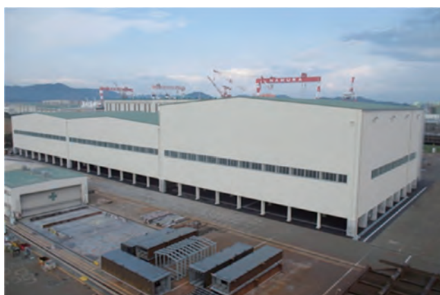
写真2 ブロックヤードNo.3~5 (B棟) 南側から撮影
