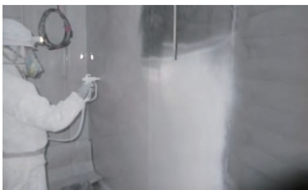
写真4 スプレー塗装作業中
