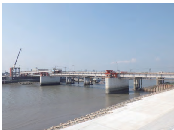
写真 20 G1 桁縦送り (1 回目)
