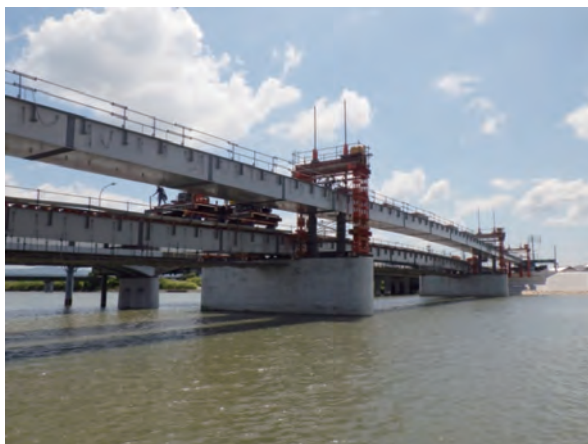
写真 28 G1 桁降下前
