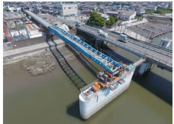
写真10 G2 桁送り出し(1回目)
