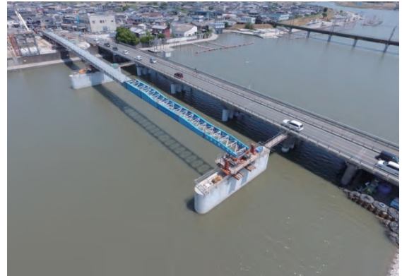
写真11 G2 桁送り出し(3回目)
