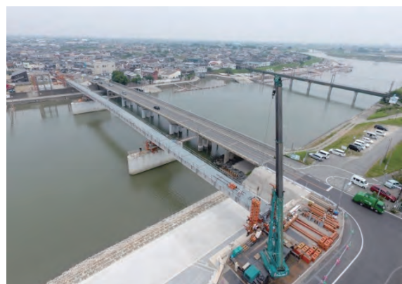
写真12 G2 桁送り出し完了
