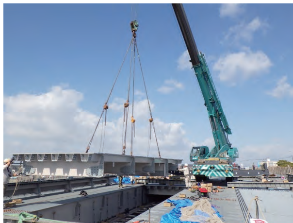
写真 30 横桁・鋼床版架設状況
