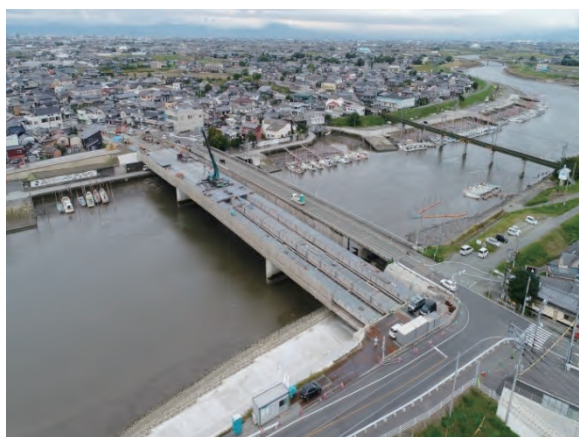
写真 31 横桁・鋼床版架設状況(全景)
