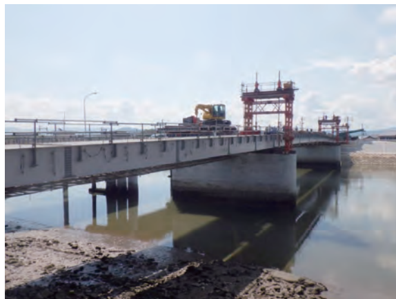
写真 29 G1 桁降下完了(3.0m)
