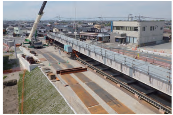
写真9 G2 桁架設状況
