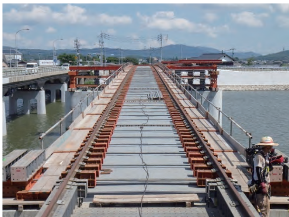
写真 18 G2 桁上軌条設備
