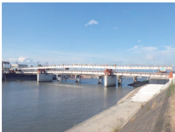
写真 22 G1 桁縦送り完了
