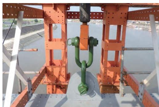
写真 15 桁吊り下げ箇所
