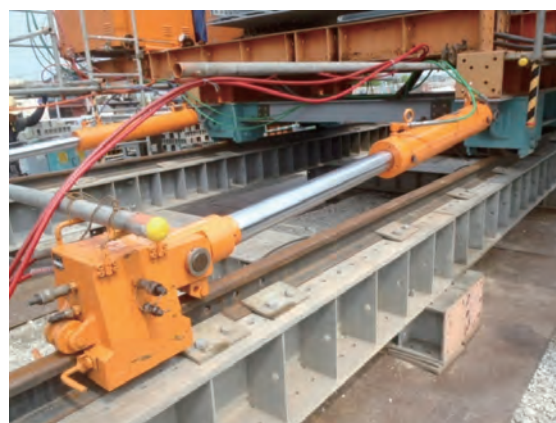
写真6 推進用ジャッキ
