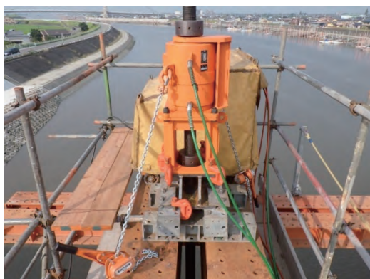
写真 14 降下装置(2,500kN)
