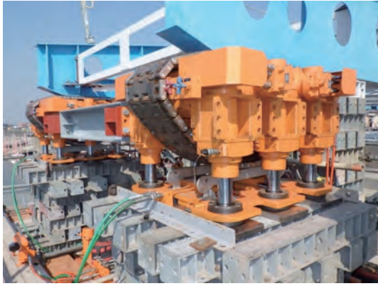
写真7 駆動式シンクロジャッキ
