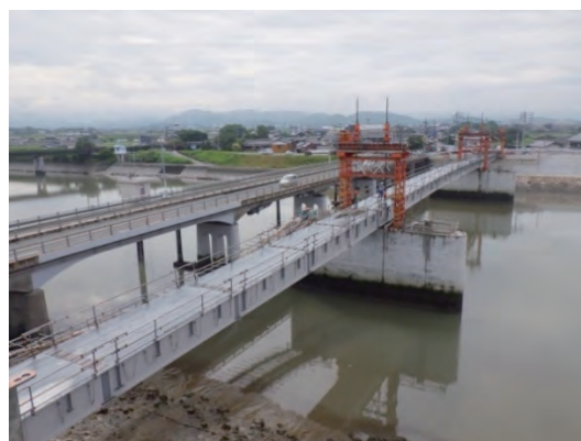
写真 17 G2 桁降下完了(2.4m)
