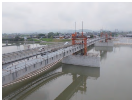
写真 16 G2 桁降下前
