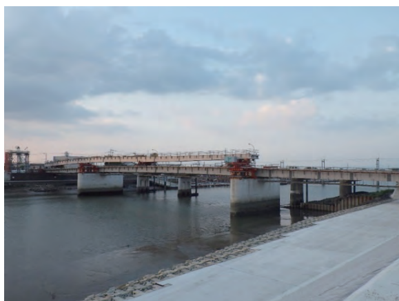
写真 21 G1 桁縦送り (2 回目)
