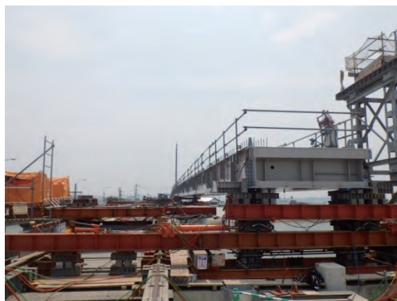
写真 25 G1 桁横取り完了 (5.4m)
