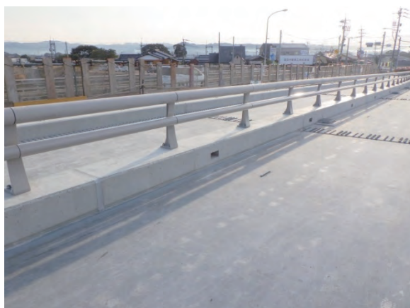
写真 32 地覆・防護柵
