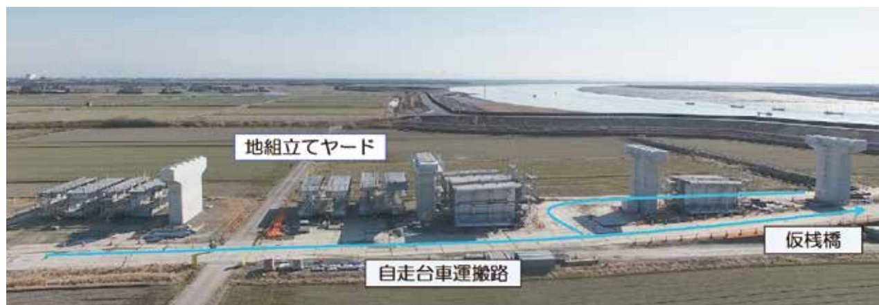
写真3 隣接工区の作業ヤードで地組立
