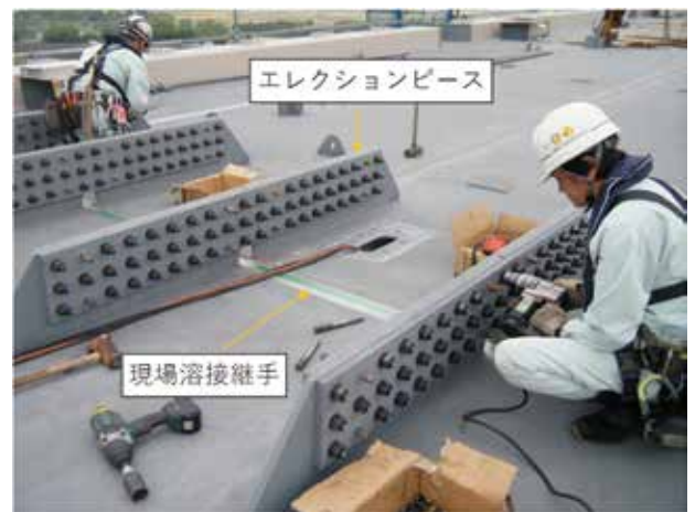
写真5 鋼床版デッキ上のエレクトロニクス
