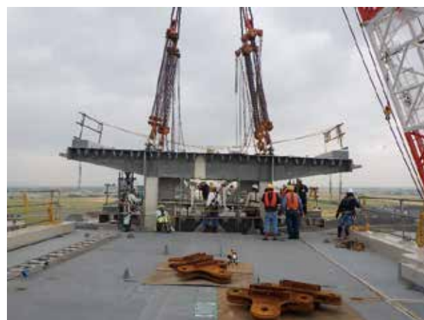
写真9 閉合ブロック落とし込み状況
