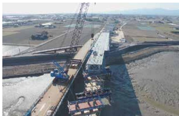
写真2 仮栈橋から側径間を架設
