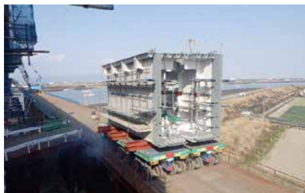
写真1 自走台車で仮栈橋まで運搬
