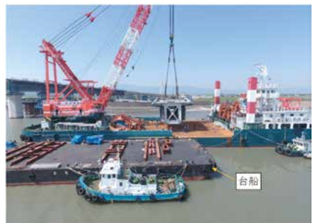
写真6 地組立ブロックの積み替え作業
