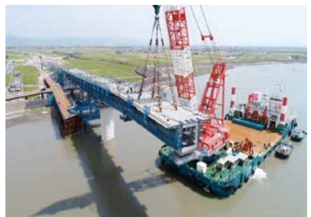
写真7 クレーン船による地組立ブロックの張出し架設
