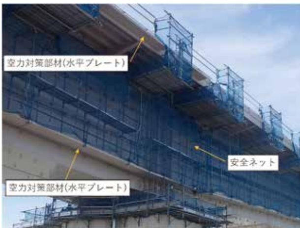
写真 11 架設形断面の足場形状
