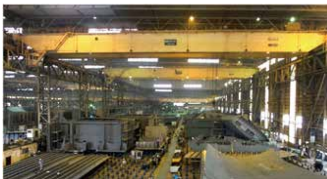
写真 3 第 1 船殻内業工場内部
