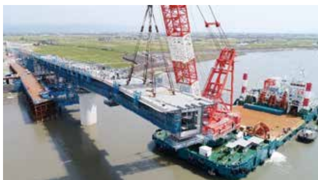
写真 14 架設中の六角川大橋
