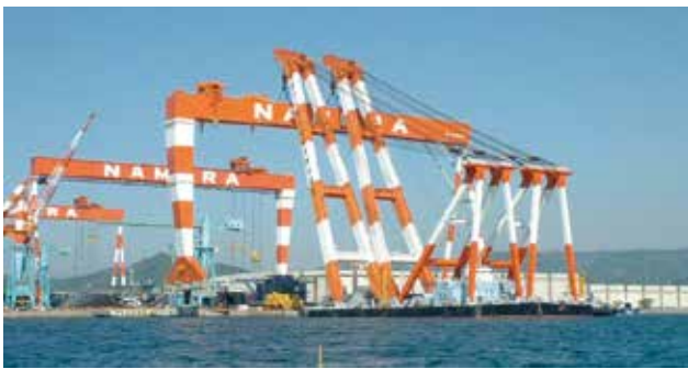
写真7 ゴライアスクレーン新設風景
