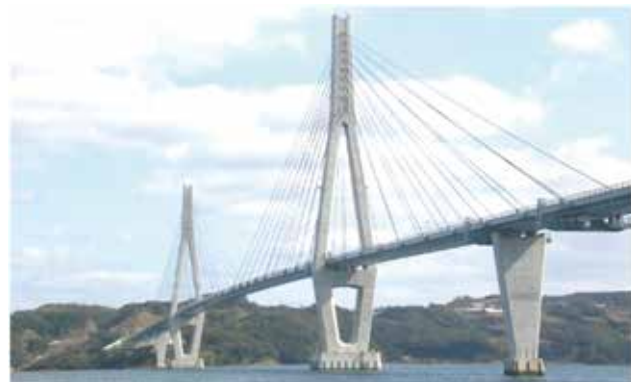
写真 13 鷹島肥前大橋
