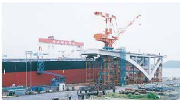
写真 12 2号岸壁で地組立される伊万里湾大橋
