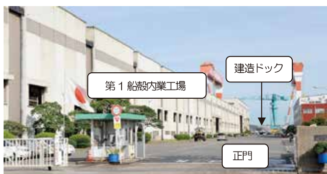
写真 4 正門から建造ドック方面を望む
