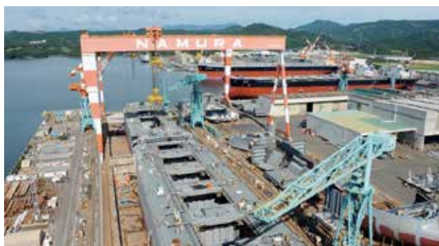
写真 5 建造ドック・4A 総組定盤
