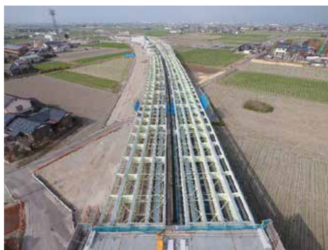
② 佐賀 208 号諸富高架橋上部工（下り線 P7-P12） 竣工写真
