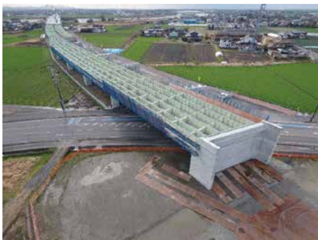
① 佐賀 208 号諸富高架橋上部工（上り線 P12-A2） 竣工写真
