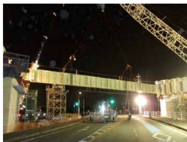
写真 4 上り線 (P12-A2) 夜間架設状況
