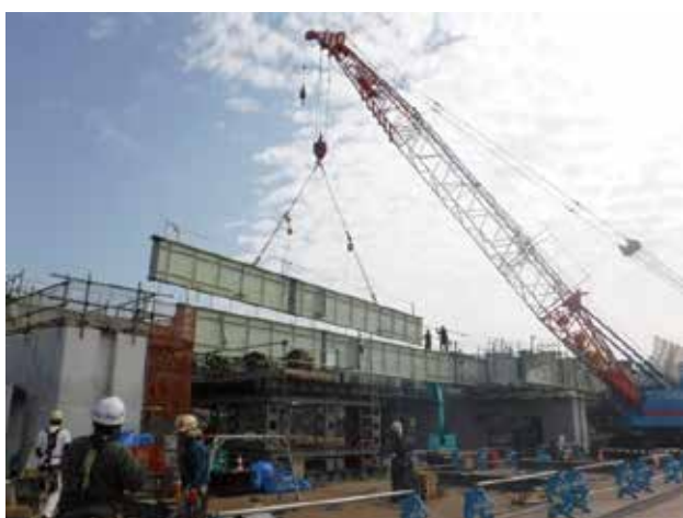
写真 1 下り線 (P7-P12) 架設状況
