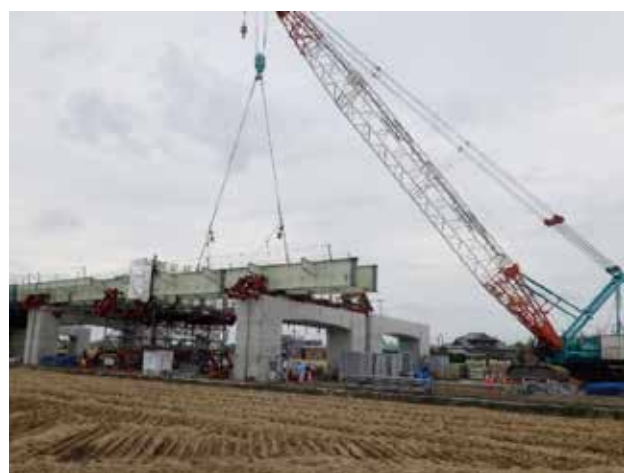
写真 2 上り線 (P12-A2) 架設状況
