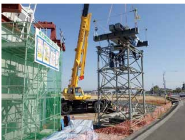
写真 3 上り線 (P12-A2) 横倒れ座屈防止用ベント
