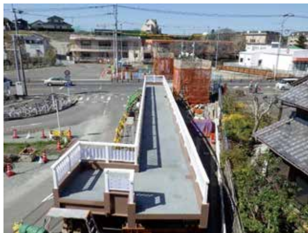
写真2 通路桁の地組立て完了
