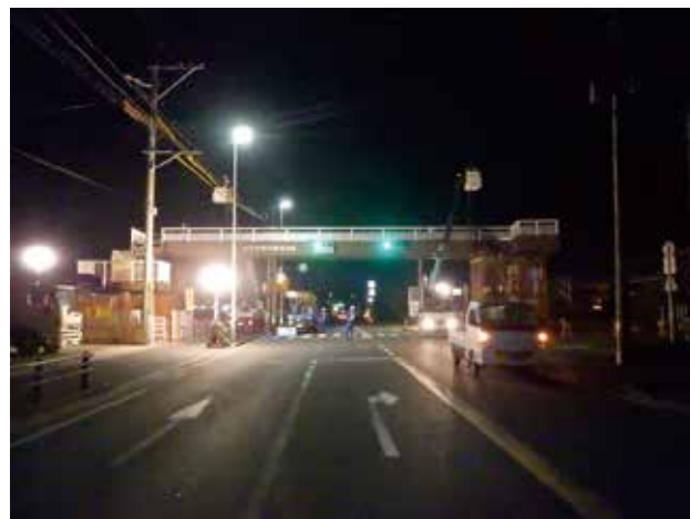
写真4 信号機・照明設備の取付け状況
