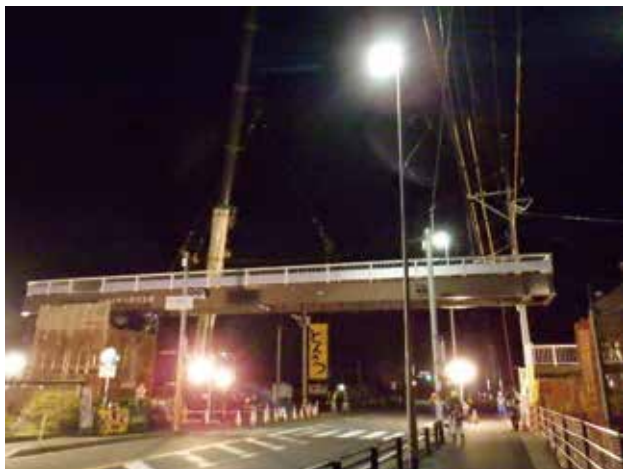
写真3 通路桁の架設状況
