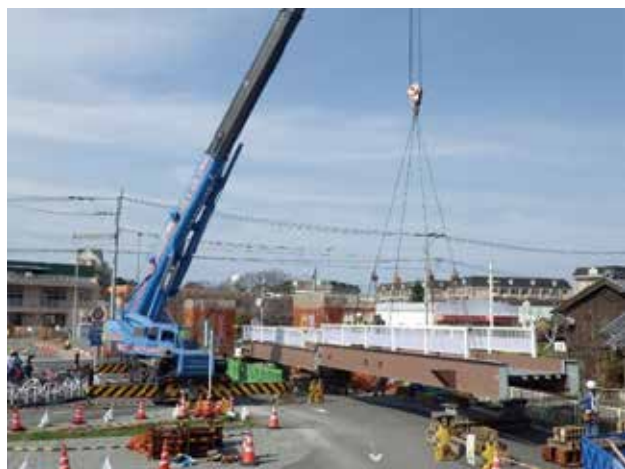
写真1 通路桁の地組立て状況
