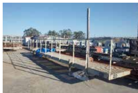
写真3 ハッチコーミング用足場
