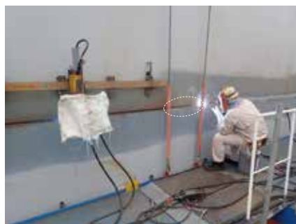
写真 24 吊りワイヤ間の石松施工不可区間
