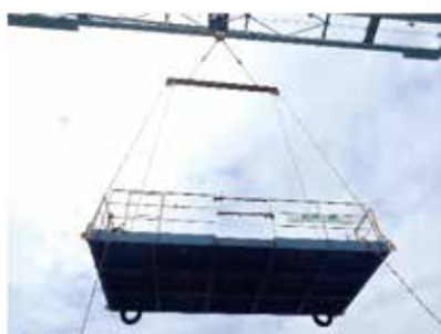
写真 18 ステージのクレーン吊り状態
