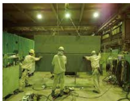
写真16 3mの大型試験片を使って実船を想定
