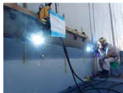
写真 21 石松溶接 + 半自動溶接
