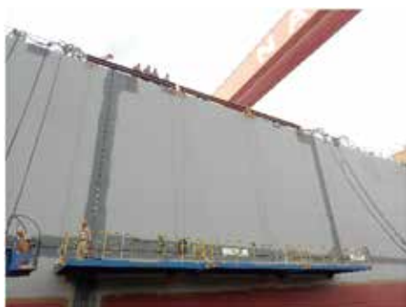
写真 19 ステージ搭載状況
