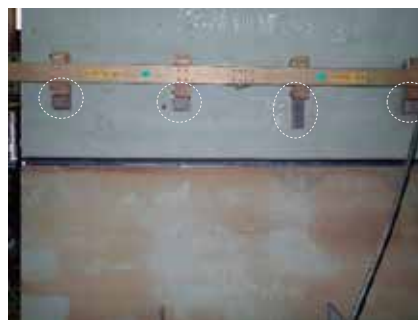
写真13 レールズレ防止のマグネット
