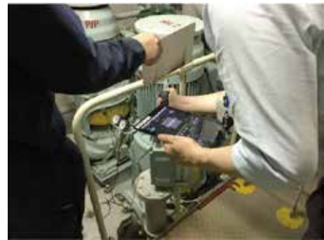
写真3 電子聴音棒使用時の様子
