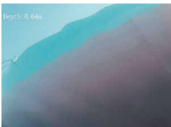
写真6 水中から外板を撮影
