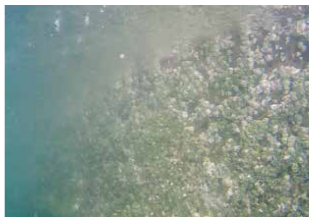
写真16 2号岸壁 水面付近
