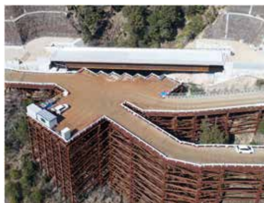
竣工写真(写真奥)
