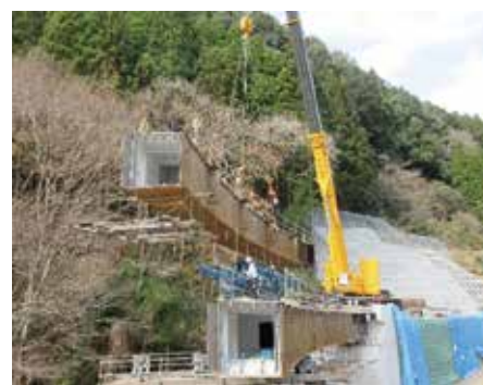
架設状況写真
