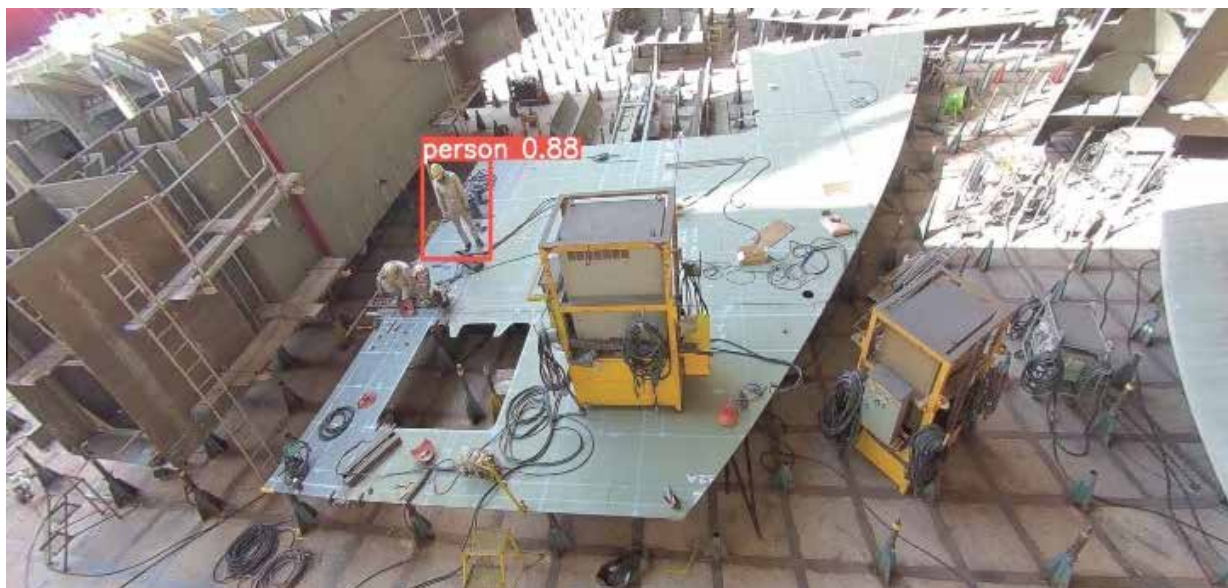
写真1 カメラによる作業員検知
